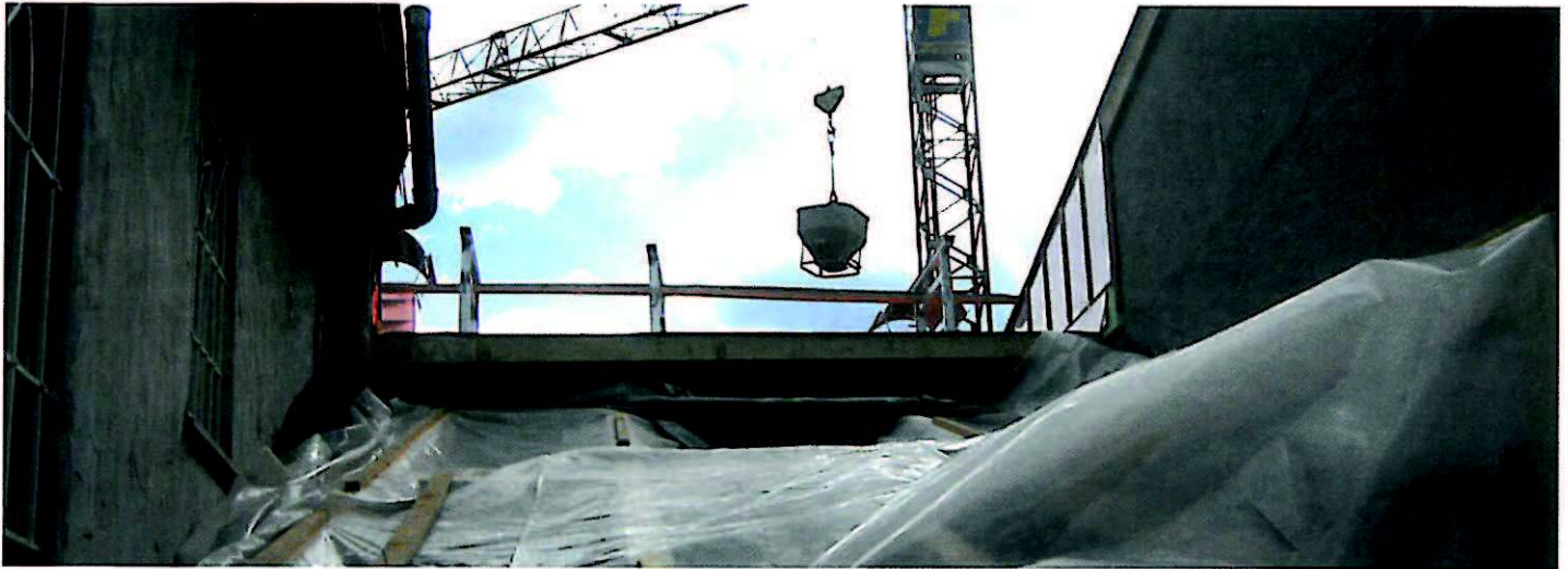
Alles Material wurde mit dem Kran transportiert
