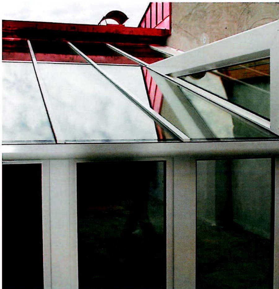
Die Glaskonstruktion des Daches mit der Kupferauflage
