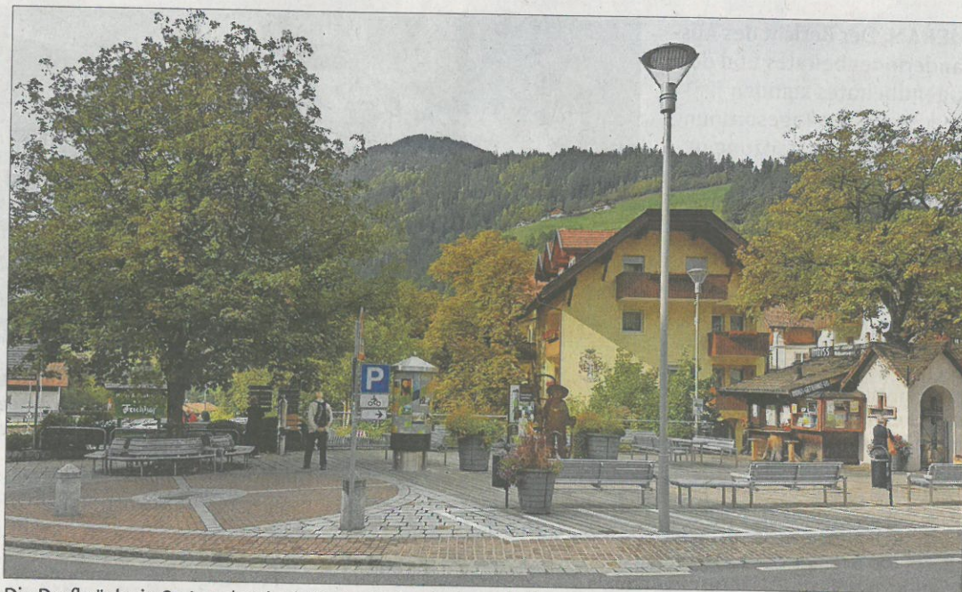
Die Dorfbrücke in St. Leonhard erhält eine Betondecke und eine neue Möblierung.
