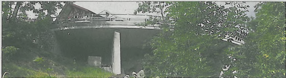
Im Bild die neue Hangbrücke an der Ortseinfahrt von Karthaus.
